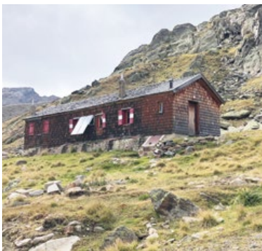
Winterhaus vor den Bauarbeiten
