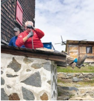
Müllraum Abbau Dach
