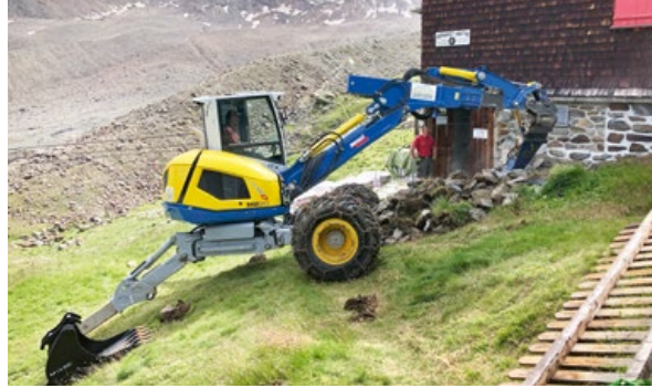
Abriss mit dem Bagger
